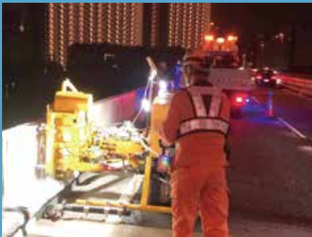
① 補強鋼板部錆除去工
