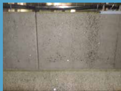
③ 施工完了
