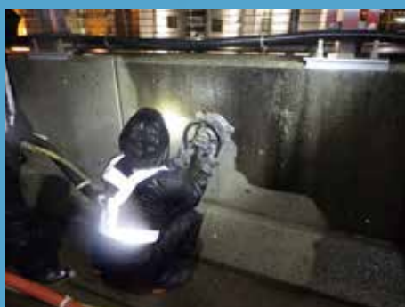
② ハンドミストジェット表面処理工
