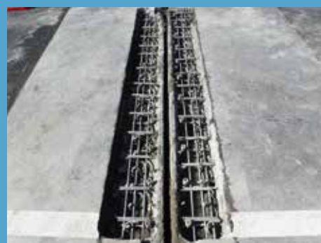
⑥ 撤去完了
