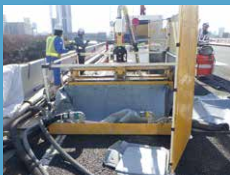
⑤ 後打ちコンクリート撤去工
