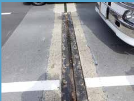
① 既設ゴムジョイント撤去
