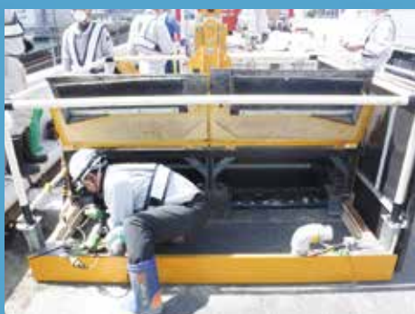
④ オートチッパー据付
