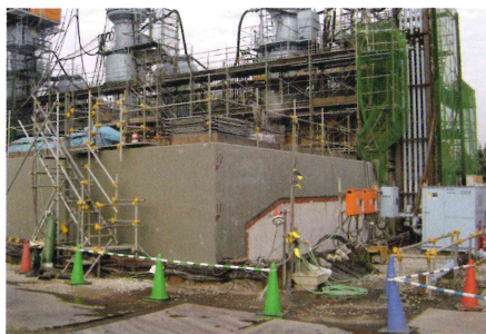
ケーソン外防水施工例
