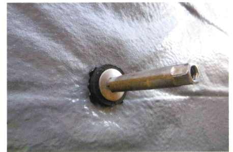
セパ部施工例
