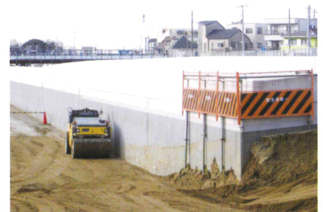
側壁部保護層無し施工例
