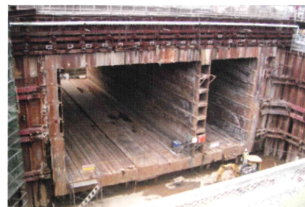
横推進工法防水施工例
