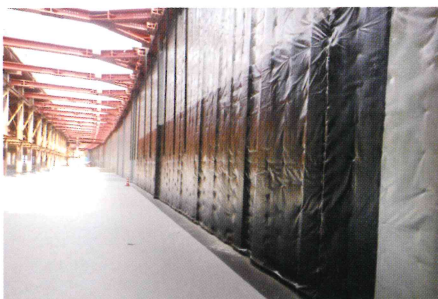
先施工防水例
