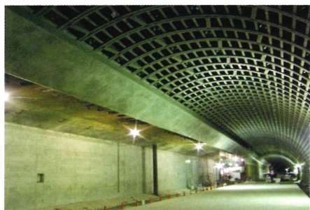
シールド鋼殻切開き部施工例
