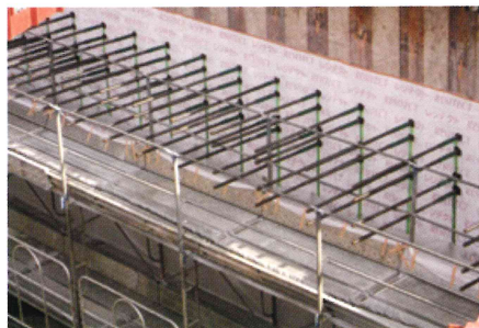
先施工ジベル筋部防水例
