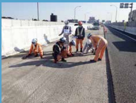
① 既設舗装撤去・事前調査
