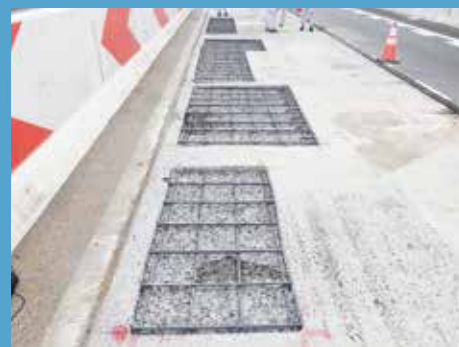
⑥ 撤去完了
