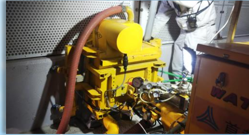
補強銅板表層錆処理施工例
