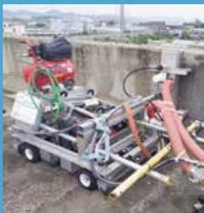
① ミストジェットによる 下地処理工
