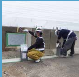
③ 専用プライマー工
