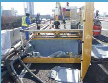
⑤ 後打ちコンクリート撤去工
