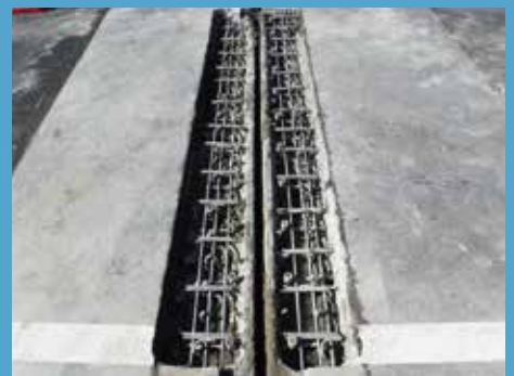
⑥ 撤去完了
