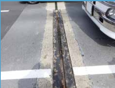
① 既設ゴムジョイント撤去
