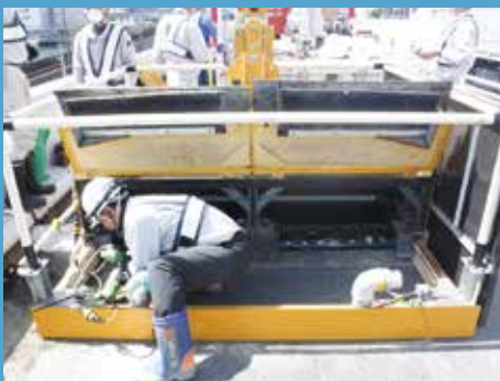
④ オートチッパー据付
