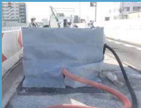
⑤ コンクリート床版損傷部撤去工
