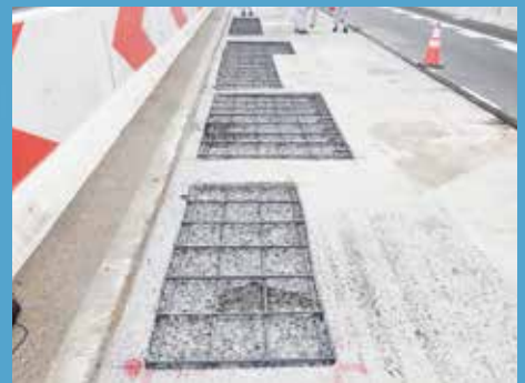
⑥ 撤去完了
