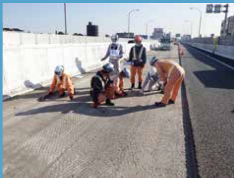
① 既設舗装撤去・事前調査
