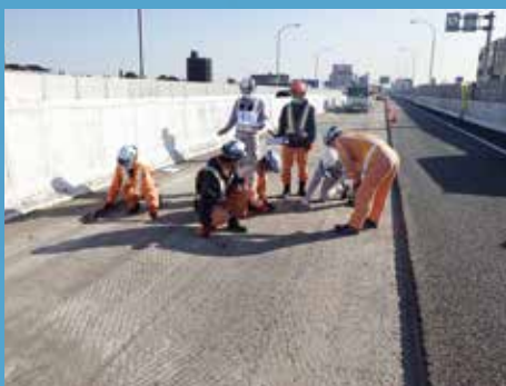
① 既設舗装撤去・事前調査
