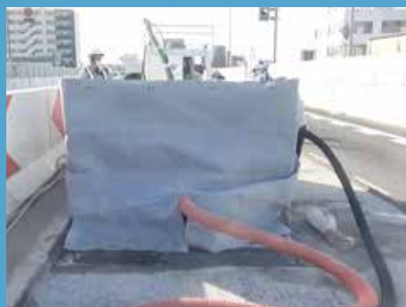
⑤ コンクリート床版損傷部撤去工
