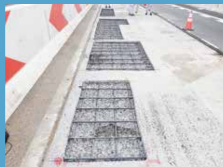
⑥ 撤去完了
